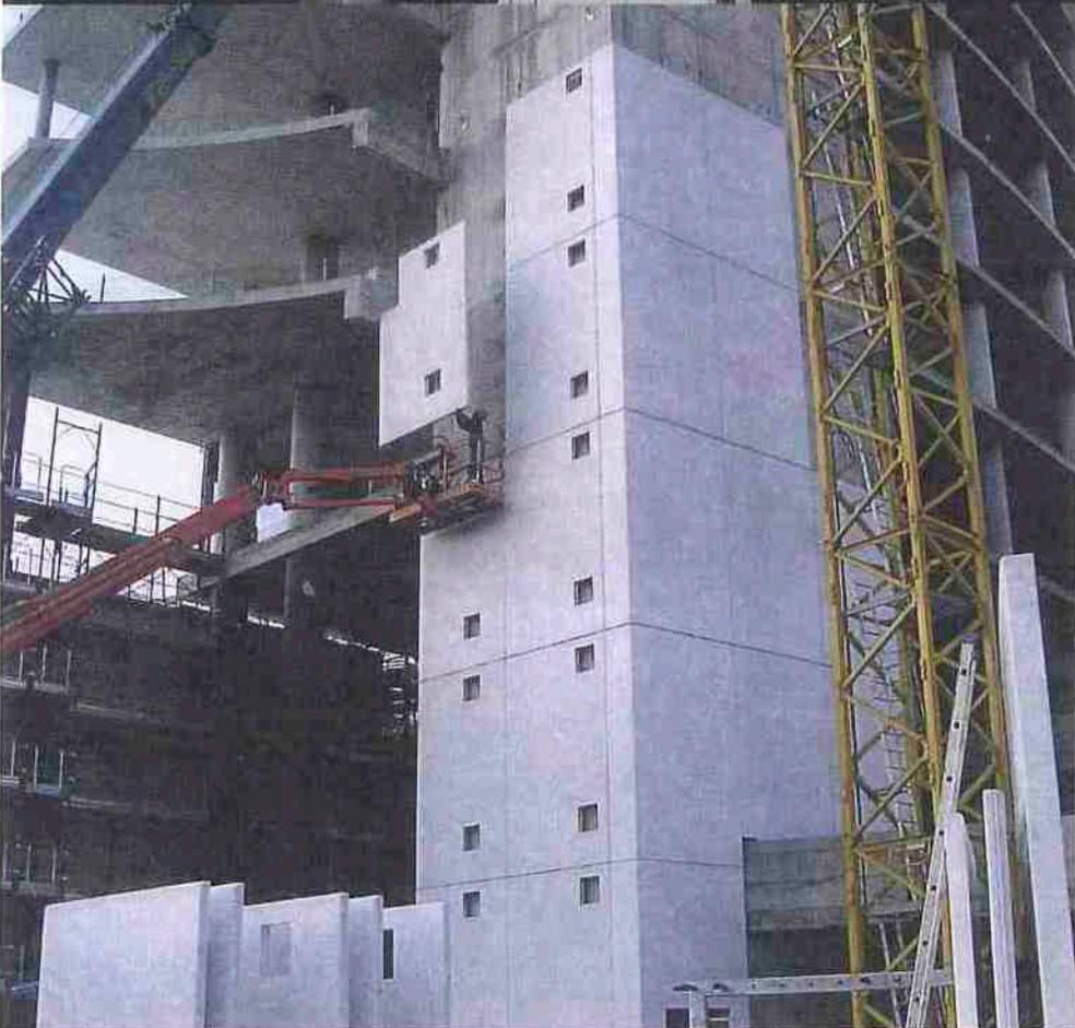
In tutti gli edifici, nelle parti dove non è presente la facciata continua vetrata, sono stati impiegati pannelli in calcestruzzo bianco fotocatalitico, antismog e autopulenti. I pannelli sono stati sollevati, posizionati in quota con l'utilizzo di autogru, lasciando libere le gru di cantiere, ancorati alla struttura in calcestruzzo armato con appositi sistemi di fissaggio a regolazione millimetrica.
