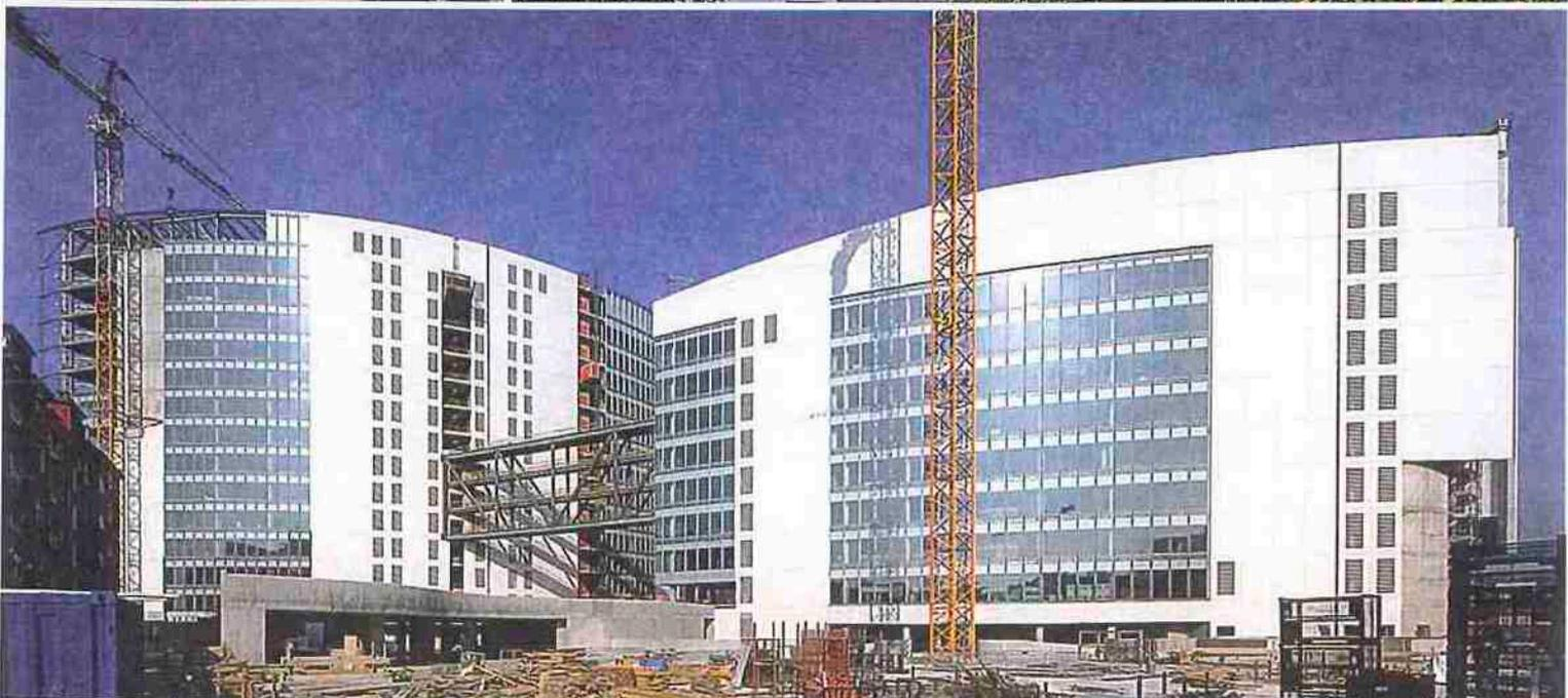
Vista generale del cantiere. Si può percepire l'enormità del lotto e la contemporaneità delle lavorazioni con compresenza di macchine e attrezzature. Le fondazioni degli edifici alti sono costituite da platee in calcestruzzo armato, mentre le fondazioni del quarto edificio e della piazza sono di tipo diretto a platea.
