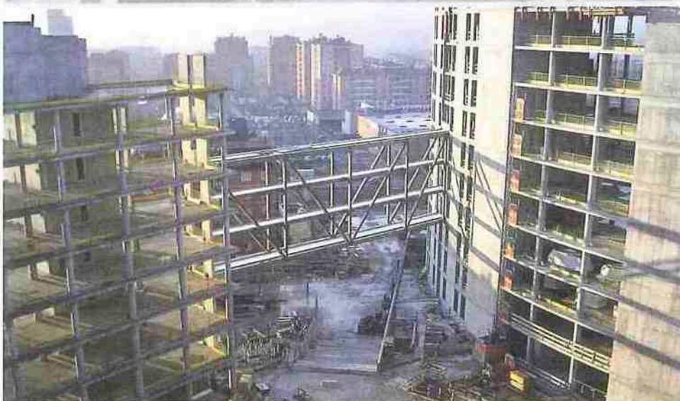
**LE PASSERELLE DI COLLEGAMENTO TRA GLI EDIFICI ALTI.** Sono realizzate con struttura in acciaio e impalcati in lamiera grecata con getto di calcestruzzo collaborante. Il ponte pedonale, lungo 40 m, che collega i piani dal 4° al 6° degli edifici A e C è costituito da due travi reticolari, alte circa 13 m, realizzate con profili Hea 600 e Heb 300 in acciaio S275jr.
