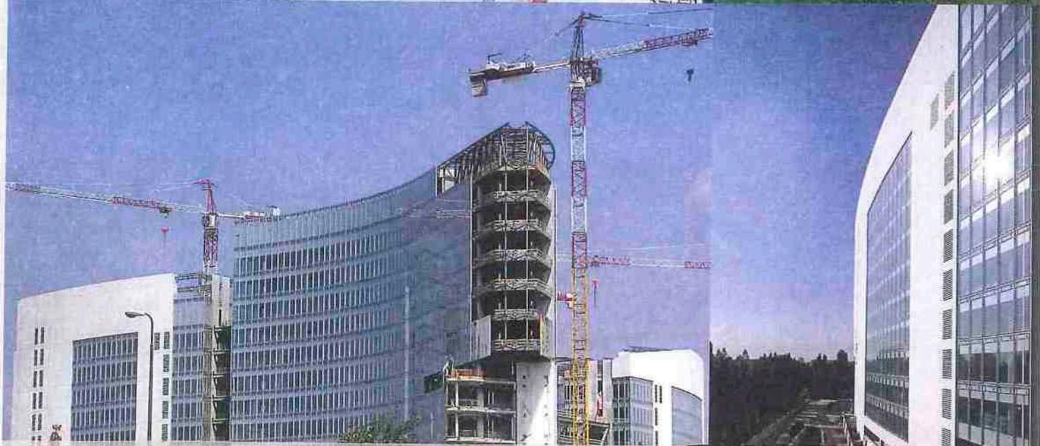
Le facciate vetrate che ricoprono la maggior superficie degli edifici sono state studiate e progettate attraverso l'utilizzo di profilati estrusi in lega d'alluminio En-Aw 6060 T5. La superficie è stata interamente suddivisa in cellule standard dall'elevate capacità termiche acustiche e di comfort interno, ancorate alle solette portanti dell'edificio mediante staffe e ferri Halfen.
