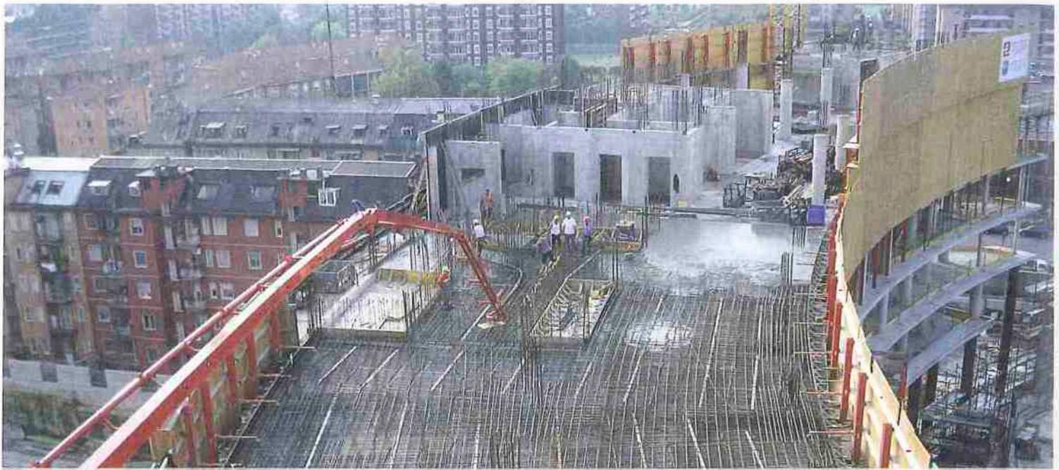
Gli orizzontamenti sono stati realizzati con tecnologia «a piastra», con solette piene in ca di classe C30/37 e spessore di 30, 40 e 45 cm. Il getto del calcestruzzo è avvenuto con pompa per il calcestruzzo a superare il dislivello del solaio e lo scudo a protezione per il lavoro delle maestranze.
