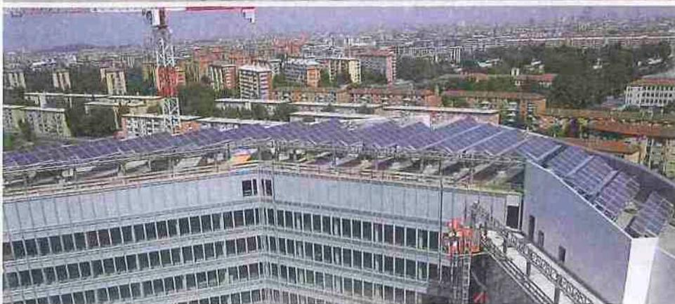
**LE TRAVI DEL GIARDINO FOTOVOLTAICO SULL'EDIFICIO A.** Lunghe fino a 13 m, sono realizzate (come le travi lungo il perimetro della copertura degli edifici alti, a sostegno dei pannelli di rivestimento e della facciata continua) con tubi tondi, con struttura reticolare tridimensionale a sezione triangolare con lato di 81 cm.
