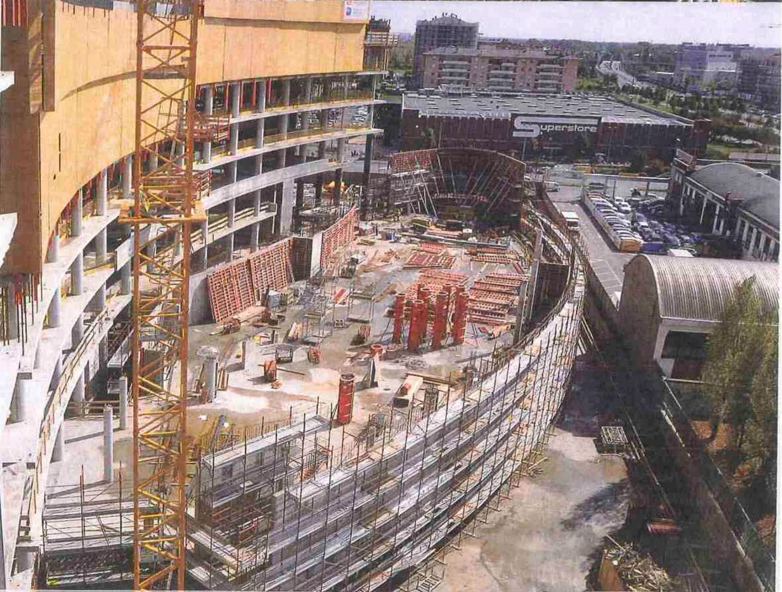
Gli elementi portanti verticali di tutti gli edifici, della piazza e dei parcheggi sono costituiti da elementi in calcestruzzo armato di classe C30/37 per i setti e pareti e C35/45 per i pilastri gettati in opera. Le pareti e i setti dei vani scala/ascensore, costituiscono, per gli edifici alti, il sistema resistente alle azioni orizzontali dovute al vento e al sisma; ai pilastri, con maglia di circa 6 m x 6 m, sono quindi stati affidati i soli carichi verticali.
